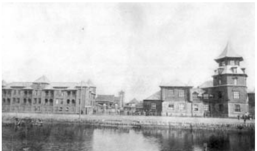
寄宿舎と六角塔(築地居留区: 1894年に着工した寄宿舎と校舎) カタカナの「口」の字形の平面形をした寄宿舎は3階建て。校舎はひらがなの「く」の字形。中央に聳える六角形5層の塔はガーディナーが耐震を考慮した苦心の作(東京地震の教訓を活かして建設)
